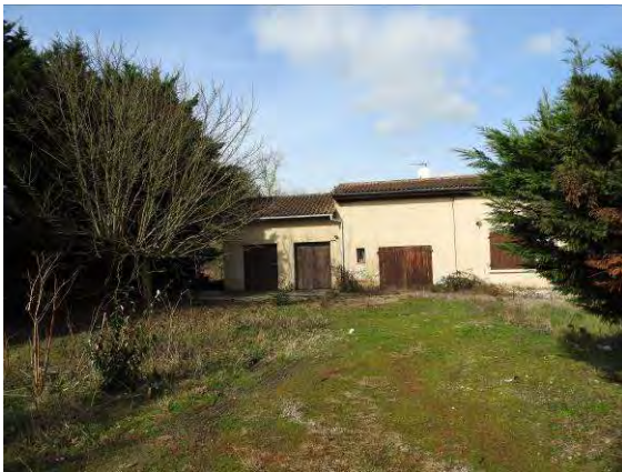
Bâtiment abandonné (Partiellement accessible)
