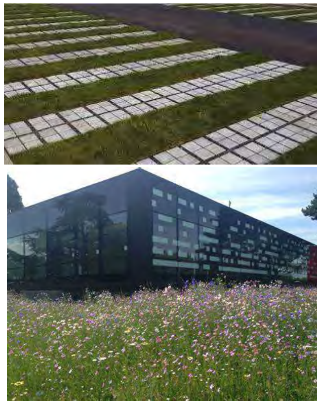
Figure 165 : Exemple de parking à la surface perméable et prairie fleurie en bordure du bâtiment
